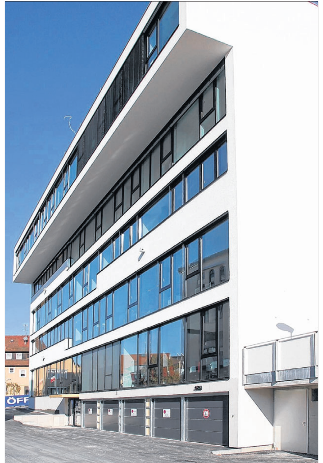
Die voll verglaste Sonnenseite der Albstraße 16-18 öffnet sich zur Markthalle hin. Fotos: Norbert Leister
